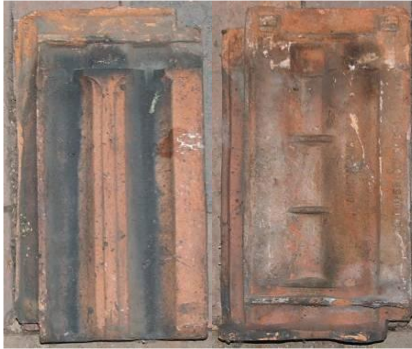
Abbildung 58: Pressfalzziegel der Andritzer Ringofenziegelei vom Ursulinenkloster, ca. 1900
