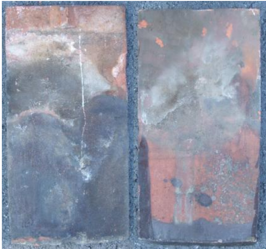
Abbildung 74: Taschenziegel, Leonhardstraße 39, glasierte Unterseite, Format 41 x 20,2 x 2,1cm, um 1800 148
