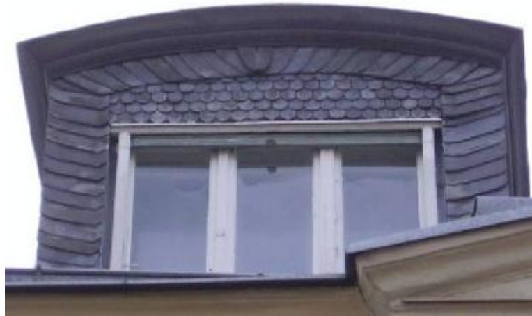
Abbildung 174: Gaubenverkleidung mit Naturschieferplatten in Schuppenform am Haus Leechgasse 28, Bestand 2006
