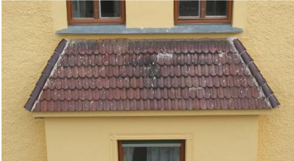
Abbildung 104: Turmfalzziegel Z3 um 1903, Ludowici, Franckstraße 31 – westseitiger Erker
