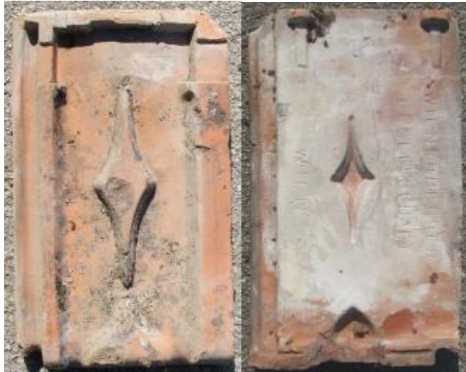
Abbildung 98: Rautenfalzziegel, Wienerberger um 1892, Hall bei Admont 162, Nebengebäude
