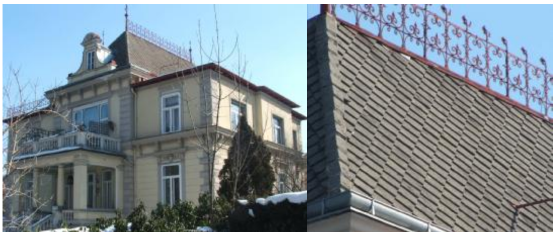
Abbildung 149: Deckung mit Zementschablonen, Schubertstr. 54
