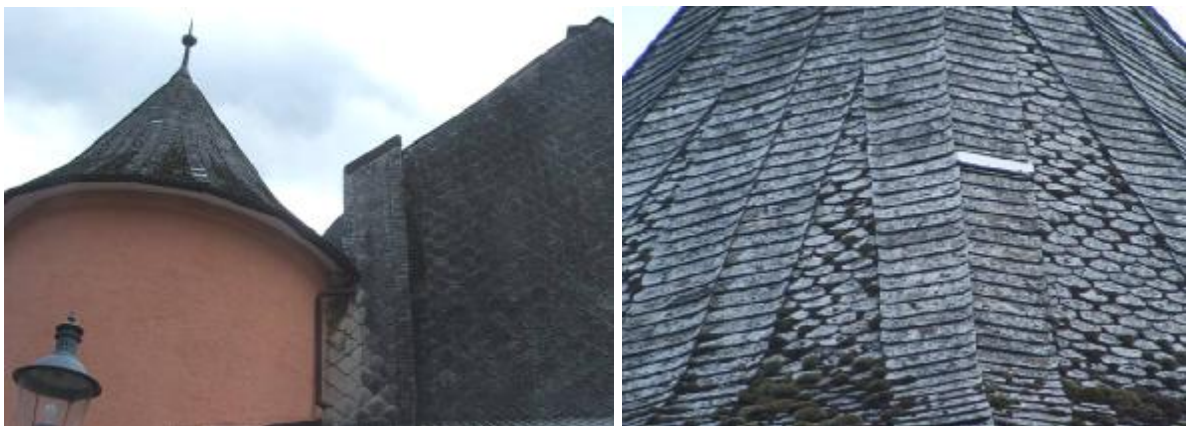
Abbildung 163: Wandverkleidung mit Wabenschablonen 30/30, Turmeindeckung mit Schuppendach am Rathaus Vordernberg
