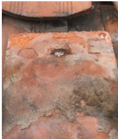
Abbildung 65: Handschlagziegel, Ende 19. Jhdt.
