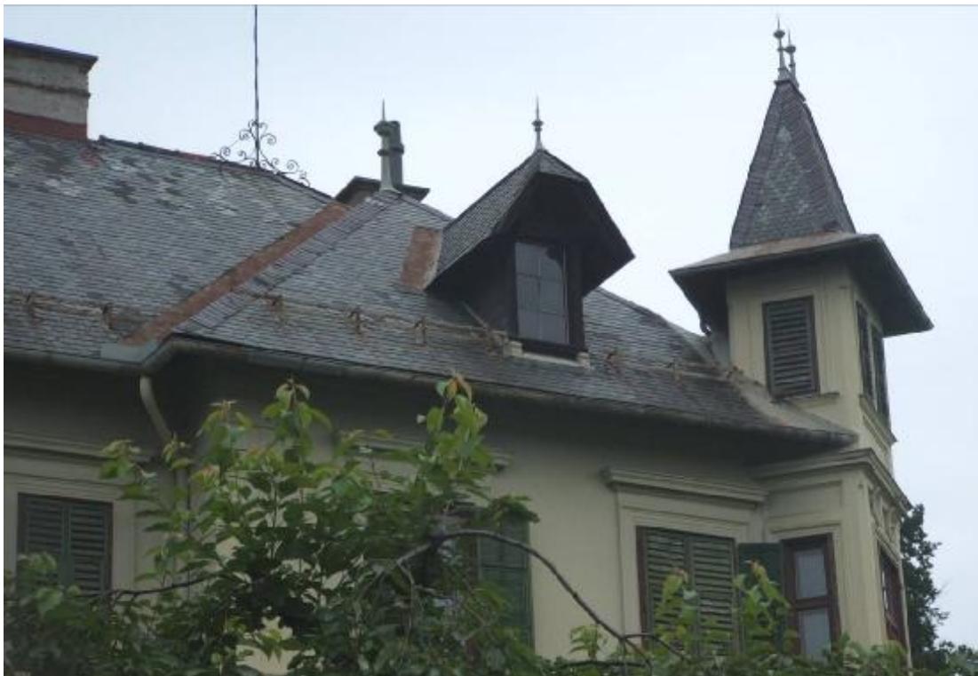
Abbildung 139: Naturschiefer-Doppeldeckung und Schuppendeckung – Rosenberggasse 28
