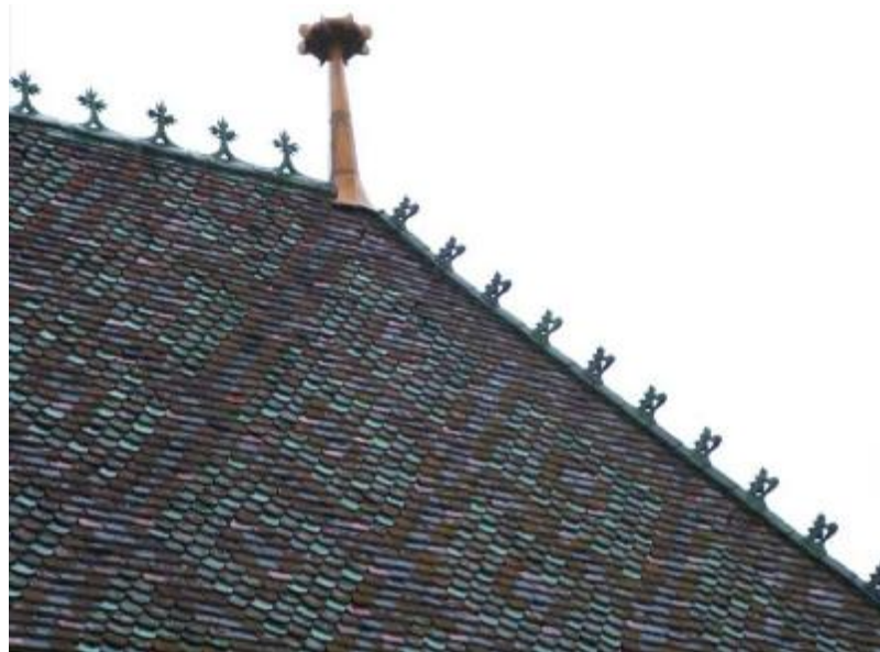
Abbildung 5: über 2 m hohes Akroterion (Knauf) an der Niklaskapelle in Basel, sowie Firstziegel mit Palmettenaufsatz
