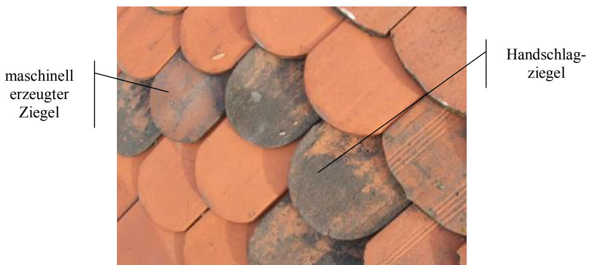
Abbildung 64: Späte Handschlagziegel und frühe Maschinenziegel am Haus Technikerstraße 7
