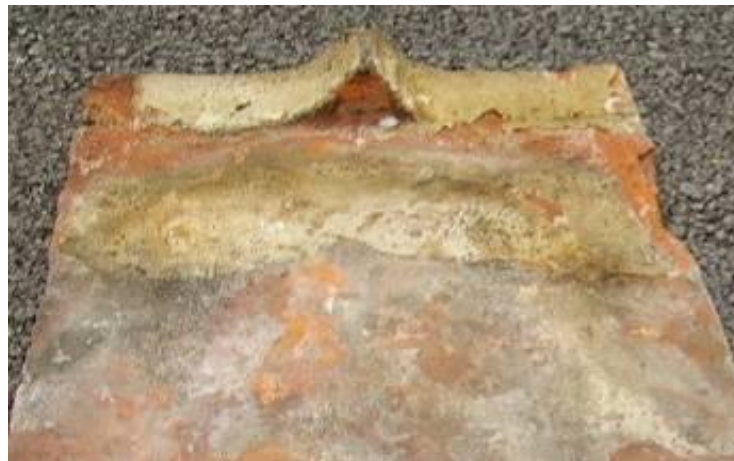
Abbildung 71: Biberschwanzziegel Hauptplatz 17, Format 42 x 21 x 1,7 cm, ca. 1840 145
