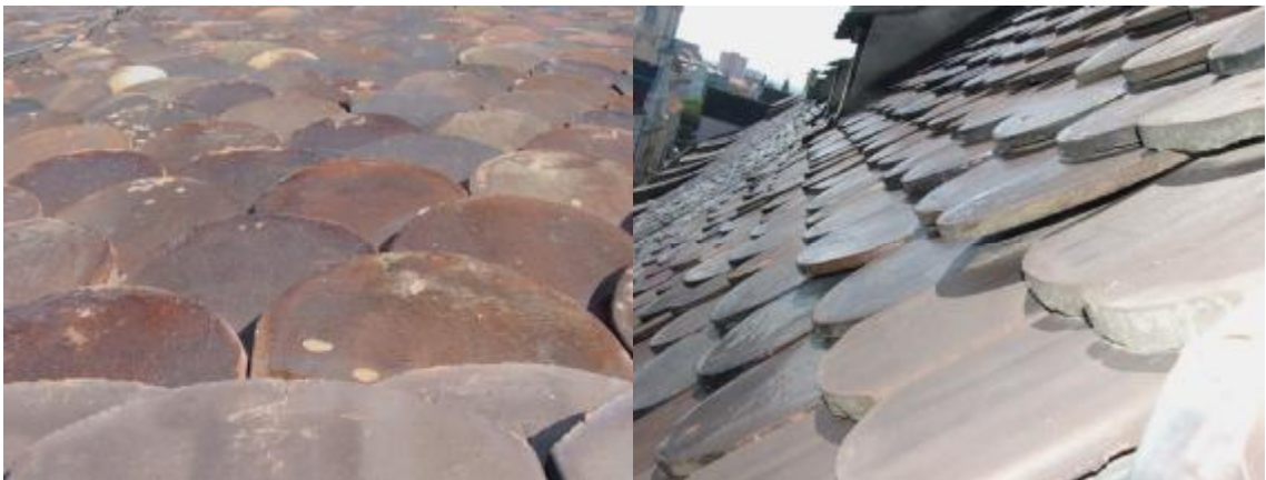
Abbildung 48: Detailaufnahme; im Bild rechts ist die vergleichsweise geringe Ziegelstärke ( \frac{5}{8} Zoll) deutlich zu erkennen
