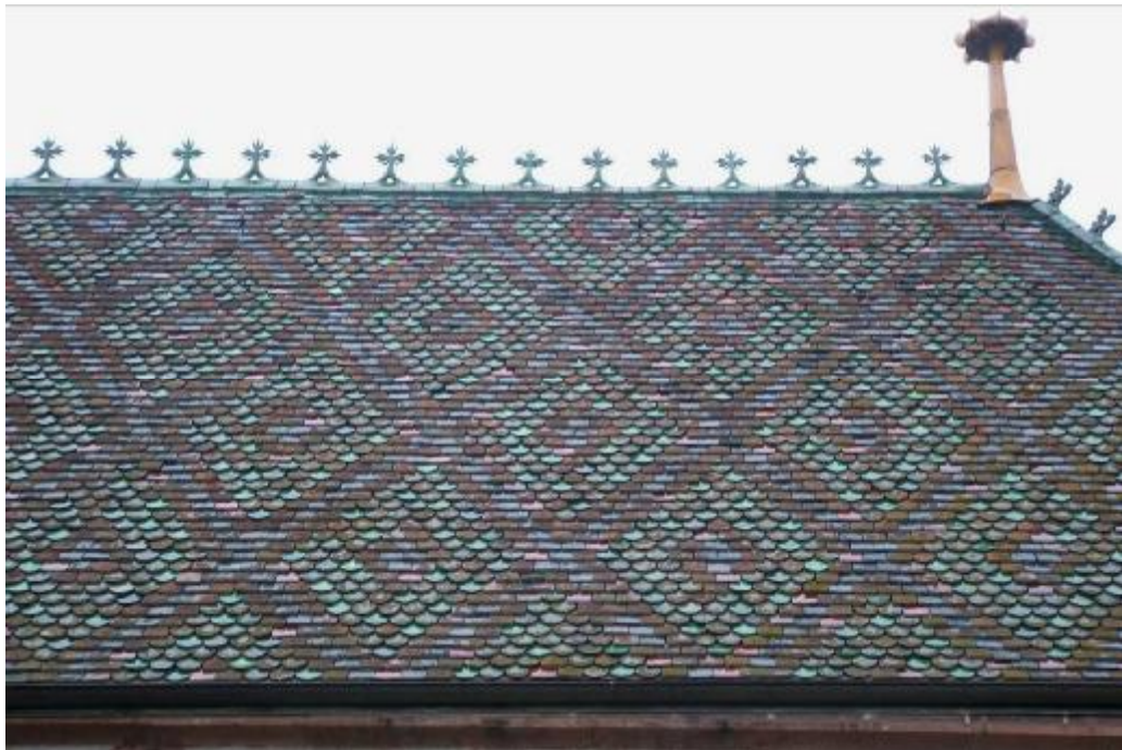
Abbildung 22: Dach der Niklauskapelle in Basel im Dezember 2005 nach einer Renovierung im Jahr 1989
