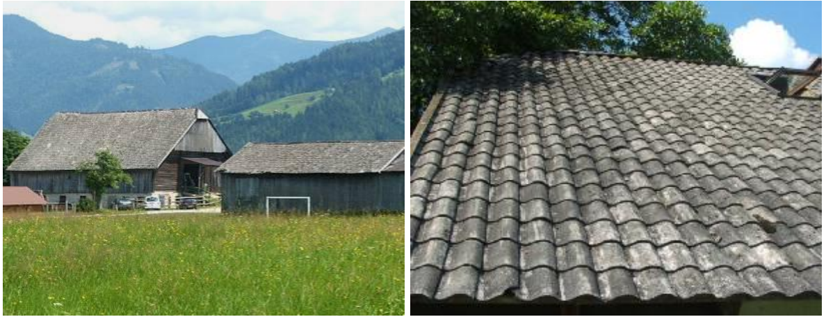
Abbildung 150: S-Pfannen am „Pürcherhof“, Mitterberg bei Gröbming
