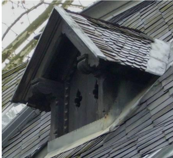
Abbildung 136: Naturschiefer-Schuppendeckung und Normalschablonen am Pförtnerhaus der Villa Ferri in der Zusertalgasse, ca. 1892
