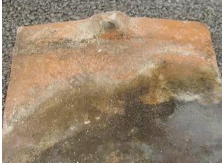
Abbildung 70: Nase des Biberschwanzziegels aus Abbildung 69, ca. 1885
