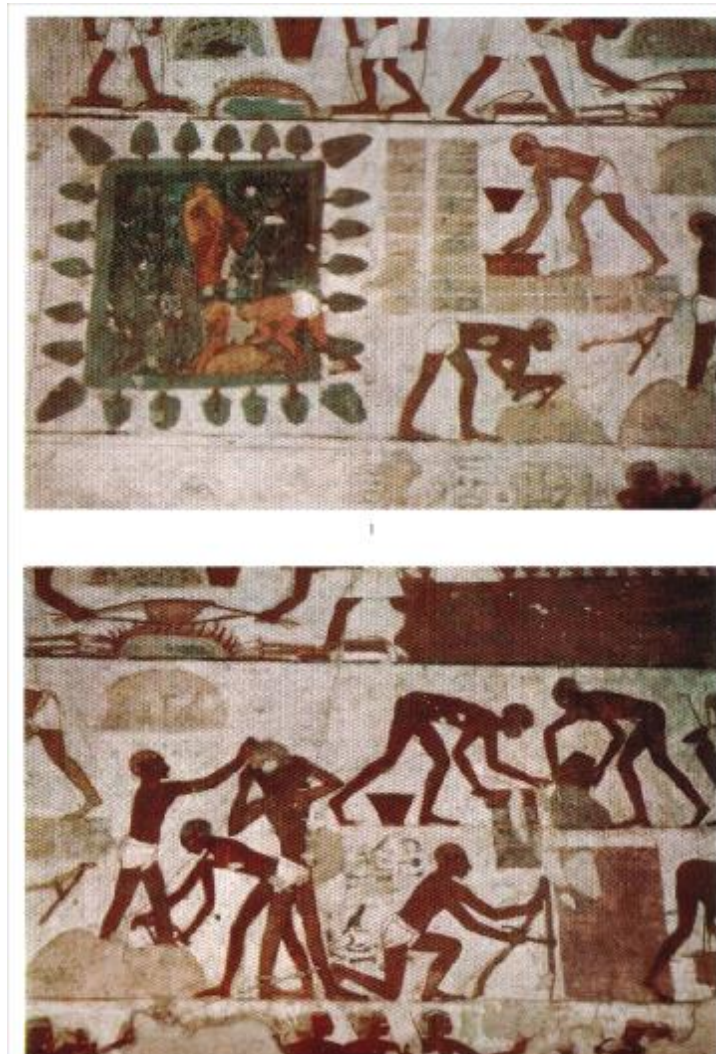
Abbildung 82: Herstellung von Lehmziegeln in Ägypten; Wandmalerei am Grab des Rehmire um 1450 v.Ch. (Salonen 1972: Tafel XLI)
