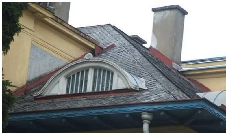
Abbildung 169: Normalschablonendeckung Johann Fux Gasse 25, Graz, ca. 1905
