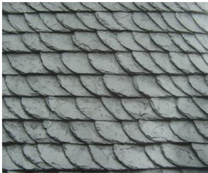
Abbildung 133: Altdeutsche Schuppendeckung (Fingerhut 2000: 11 – Ausschnitt)
