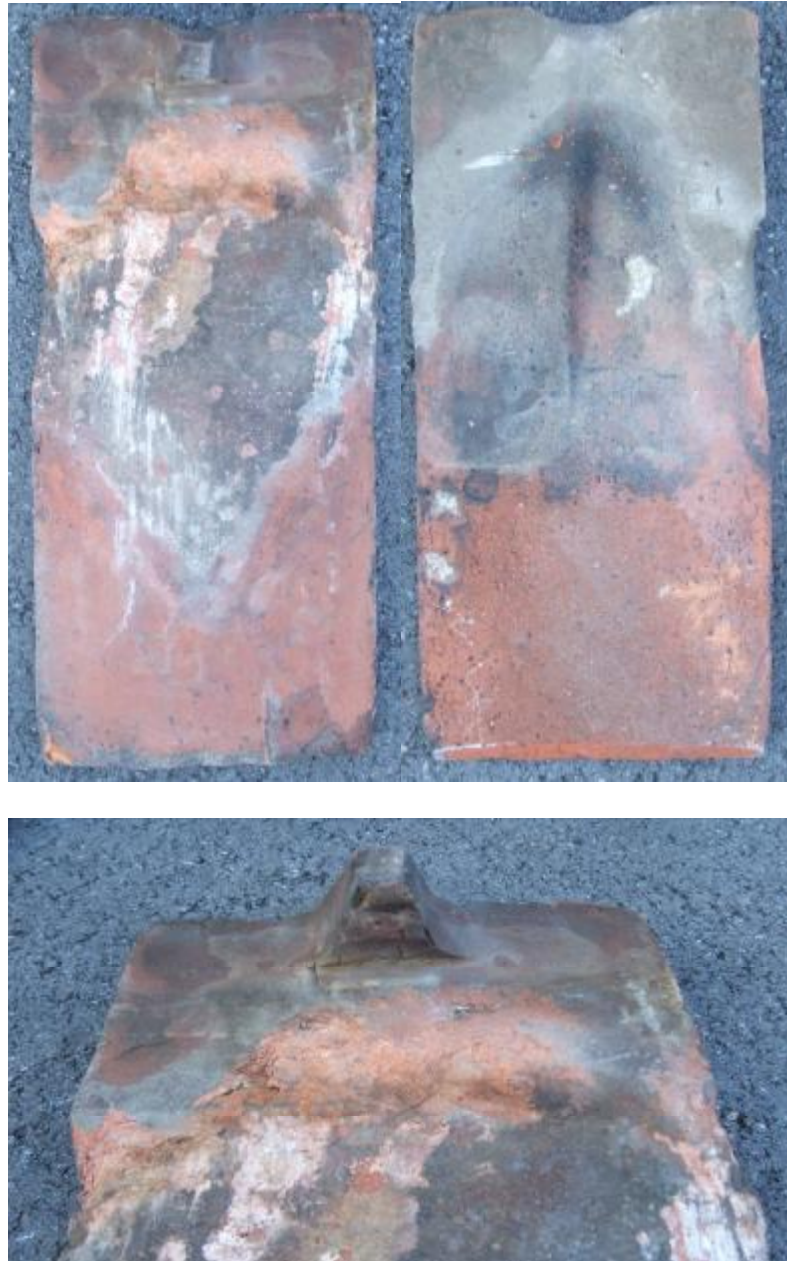
Abbildung 76: Taschenziegel vom Landhaus, abgefaste Unterkante, Nasendicke 3,8 cm, Format 44,5 x 20 x 2,1 cm, um 1560 150
