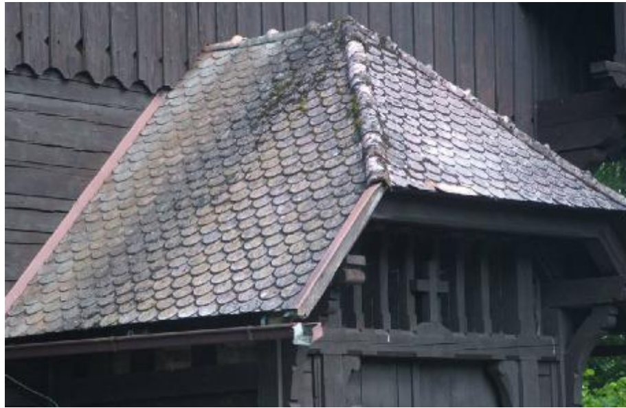
Abbildung 162: Schuppendach 40/13, Kapelle in Hall bei Admont, ca. 1905
