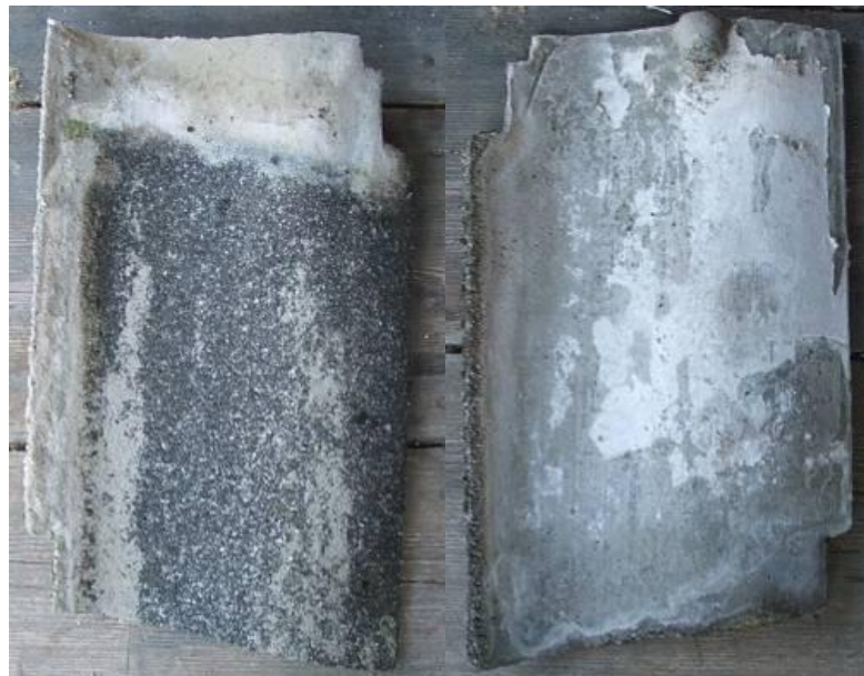
Abbildung 151: S- Pfannen vom „Pürcherhof“ aus der Zeit des 2. Weltkrieges mit Zeitungsresten; das Zeitungspapier verhinderte das Ankleben des Betons an der Form
