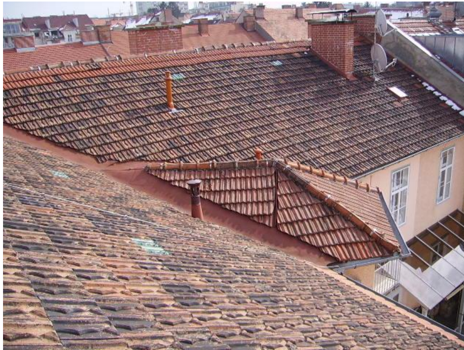
Abbildung 178: Rautenfalzziegel Bergmannngasse 22, ca. 1896
