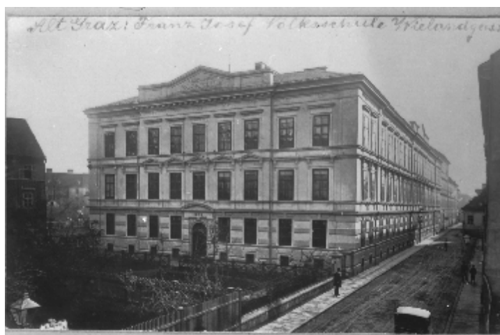
Abbildung 176: Wielandschule 1877 mit Naturschieferdach (BTA/KB51150)
